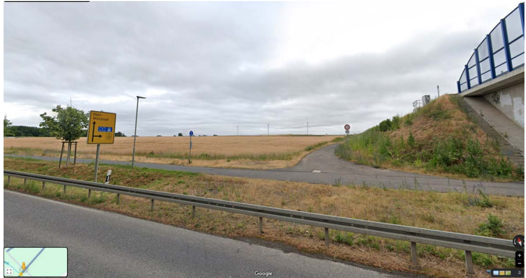
Bestandssituation – Blick vom nordwestlichen Ende der Straßenbrücke nach Norden (Quelle: Google Streetview)
