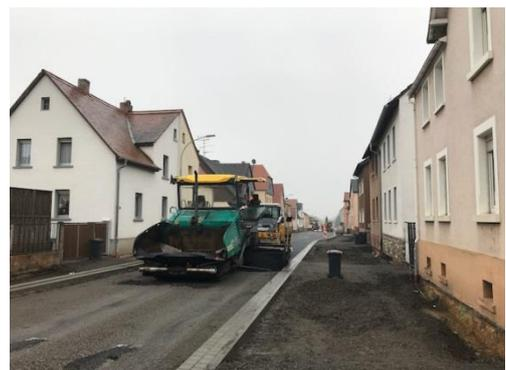
Durch die Rückbaumaßnahmen soll der Straße der Charakter einer Durchfahrtsstraße genommen werden. Die Fahrbahn wurde verengt und durch die versetzte Anordnung von Parkplätzen werden zusätzlich Fahrbahnverschwenkungen entstehen, die den fließenden Verkehr verlangsamen. Ausreichende Querungshilfen für Fußgänger sind eingeplant. Neben Kanal- und Wasserleitungen werden auch Fahrbahn, Parkstreifen, Gehwege und Bushaltestellen erneuert.
